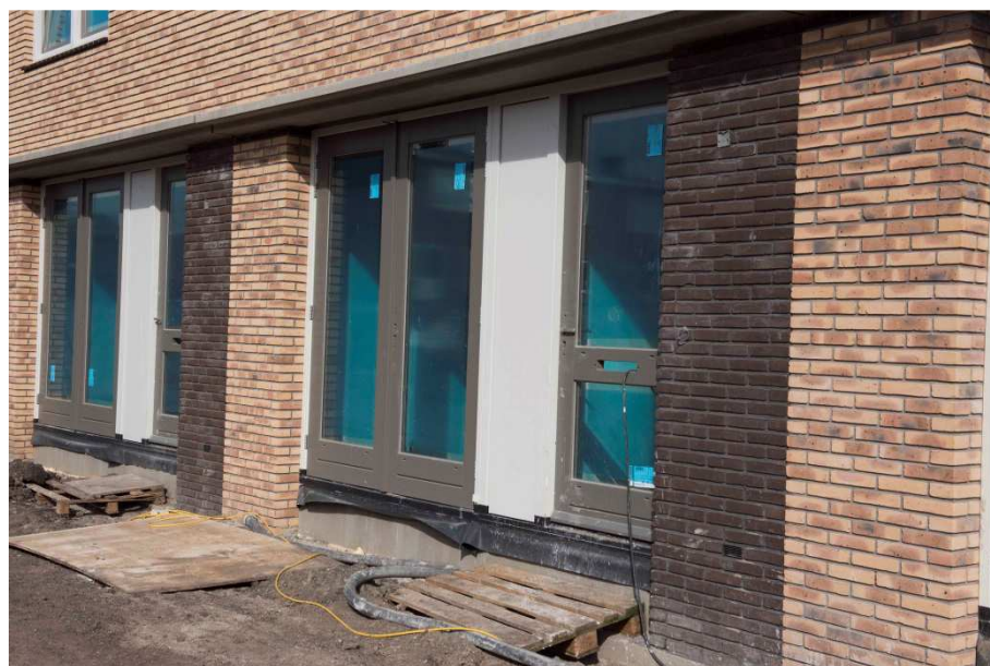
Tuinzijde eengezinswoning met openslaande deuren
