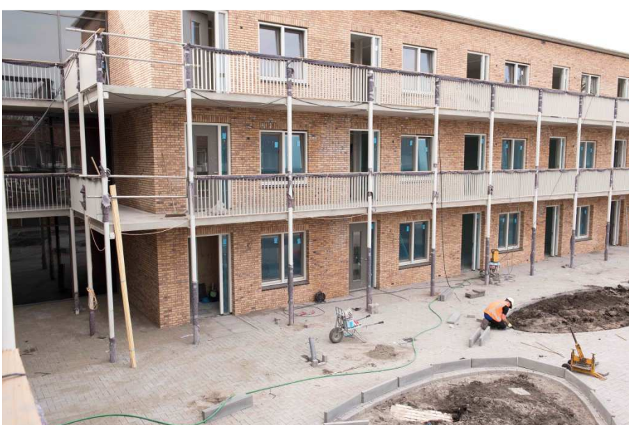
achterzijde van de 2-kamerwoningen
