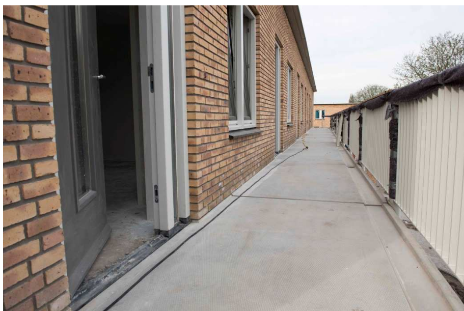
Galerij langs 2-kamerwoningen op 2e verdieping
